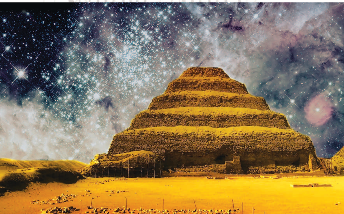
Fig. 1 - Pyramide à degrés de Saqqarah Première pyramide d'Egypte à degrés, dite à redans par assises carrées, construite dans la nécropole royale de Memphis à Saqqarah 125 x 109 m à la base, elle culmine à 62 m de hauteur (1)
