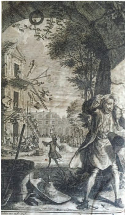
Francs-Maçons face à l'effondrement d'un édifice
